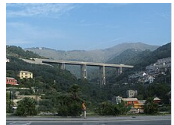
Viadotto autostradale dell' Autostrada A12 nei pressi di Genova Nervi
