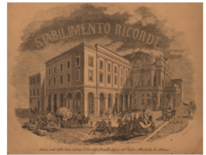
Antica sede della casa editrice G. Ricordi & C. nell'edificio adiacente al Teatro alla Scala di Milano, che si intravede sulla destra
