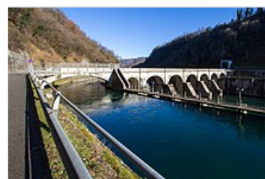
Centrale idroelettrica Semenza a Robbiate, in provincia di Lecco, lungo il fiume Adda
