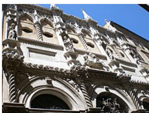
La Loggia dei Mercanti di Ancona, simbolo della potenza marinara cittadina.
