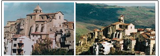
Castellino del Biferno: i danni del sisma del 2002 alla chiesa madre, e il successivo restauro
