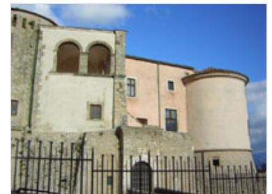
Castello Pandone (veduta laterale)
