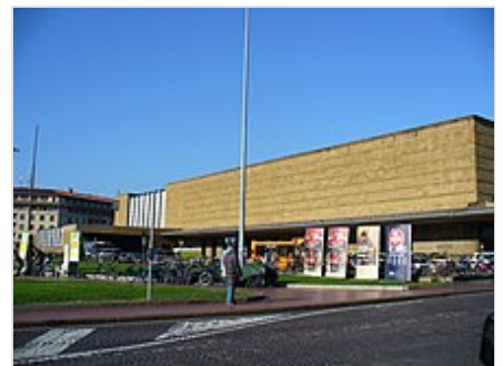
Stazione di Firenze Santa Maria Novella , la più importante della Toscana ed una delle principali stazioni italiane
