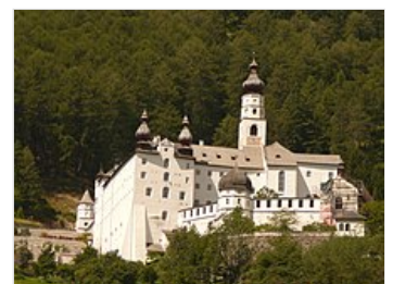
L'abbazia di Monte Maria , presso Burgusio di Malles
