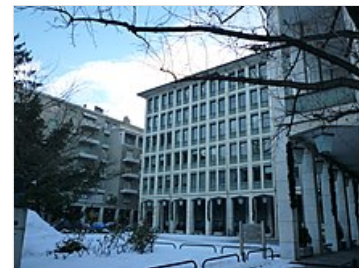
Sede dell'amministrazione regionale in piazza Albert Deffeyes ad Aosta
